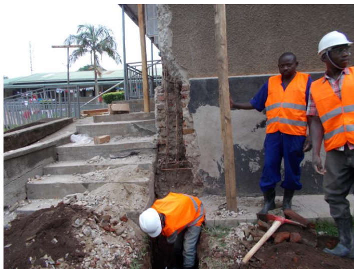
Det måtte graves dypt for å få fundament på plass
