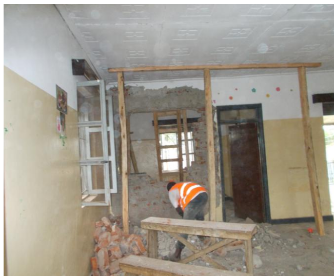
Her er innvendig arbeidet godt i gang.
