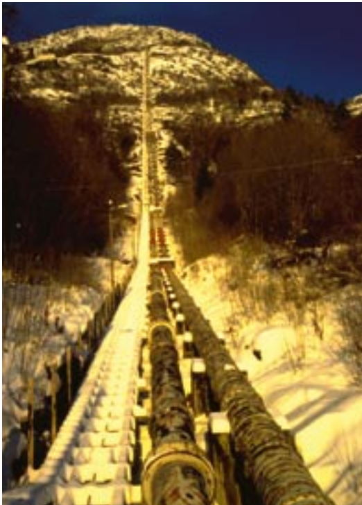
FIGUR 8-1 RØYRGATE TIL HØGTRYKKSVERK
